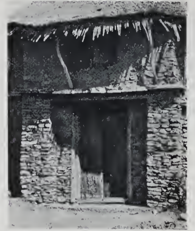
Abb. 65. Tür aus Bambusstäben mit Lehmüberzug. Aksum.
